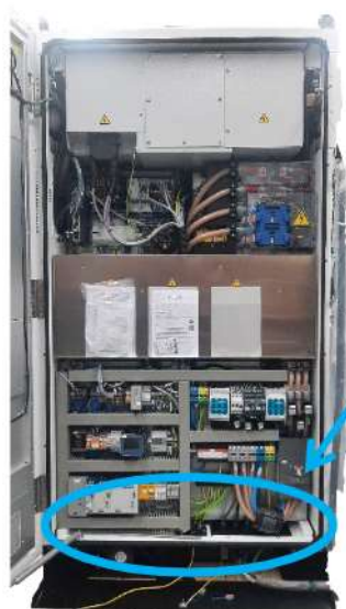
ABBILDUNG 45: SOCKELBEREICH AUF FEUCHTIGKEIT PRÜFEN (WECHSELRICHTERSEITE)
