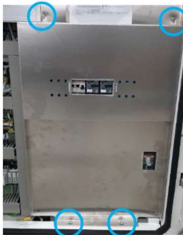
ABBILDUNG 27: ABDECKBLECH AM HAUPTSCHALTER MONTIEREN
