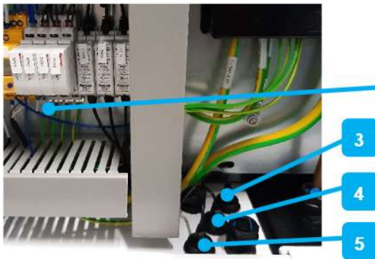
ABBILDUNG 35: KOMMUNIKATIONSLEITUNGEN INNEN – VORMONTIERT
