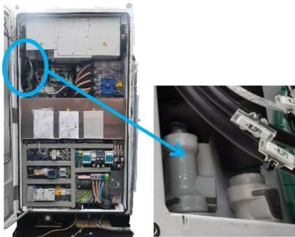
ABBILDUNG 52: KÜHLSCHLÄUCHE PRÜFEN (WECHSELRICHTERSEITE)
