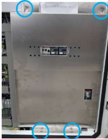
ABBILDUNG 26: ABDECKBLECH AM HAUPTSCHALTER DEMONTIEREN
